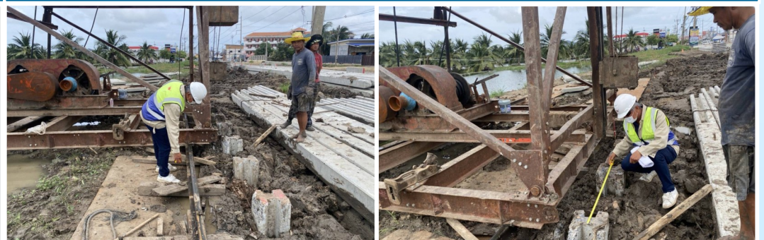
ตรวจสอบและควบคุมงานเสาเข็มตอกหล่อสำเร็จ (สำหรับกำแพงกันดินแบบเสาเข็มปลายยื่น)
