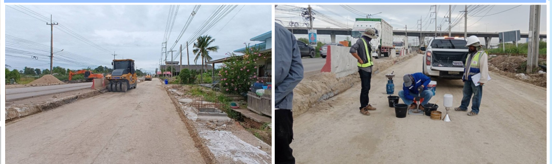
ตรวจสอบและควบคุมงานทรายถมคันทาง
