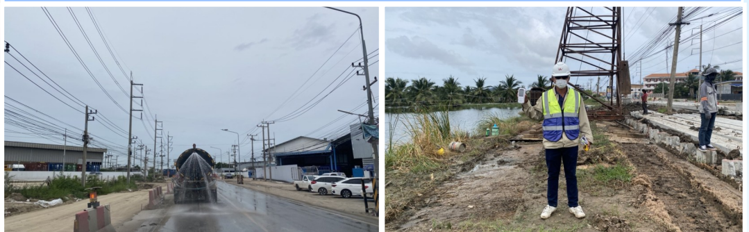
งานรตน้ำป้องกันฝุ่นเพื่อลดมลภาวะในการก่อสร้าง และตรวจสอบ PM. 2.5
