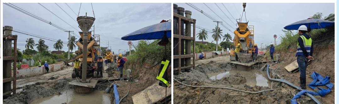
ตรวจสอบและควบคุมงานเสาเข็มเจาะหล่อในที่ ขนาดเส้นผ่านศูนย์กลาง 1.00
