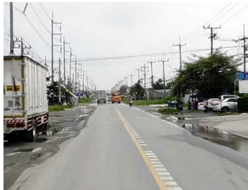
รูปก่อนการก่อสร้าง กม.ที่ ๓+๙๐๐
