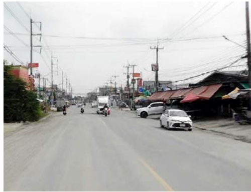
รูปก่อนการก่อสร้าง กม.ที่ ๒+๘๐๐
