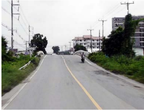
รูปก่อนการก่อสร้าง กม.ที่ ๓+๔๐๐
