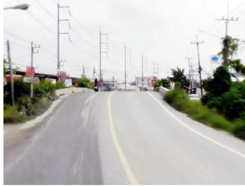
รูปก่อนการก่อสร้าง กม.ที่ ๒+๖๐๐
