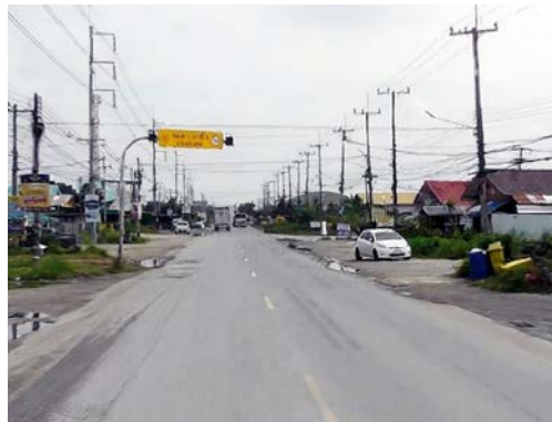
รูปก่อนการก่อสร้าง กม.ที่ ๔+๓๐๐
