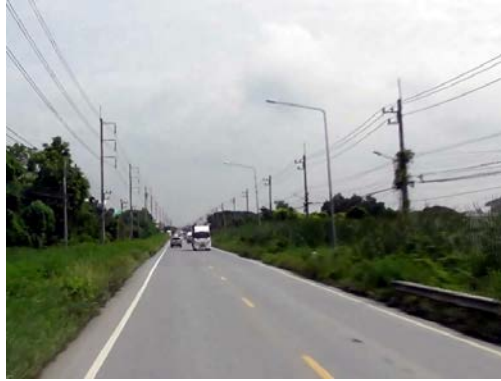
รูปก่อนการก่อสร้าง กม.ที่ ๑+๐๐๐
