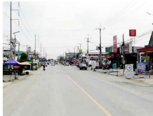
รูปก่อนการก่อสร้าง กม.ที่ ๒+๙๐๐
