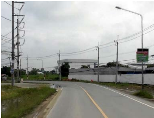
รูปก่อนการก่อสร้าง กม.ที่ ๐+๓๐๐
