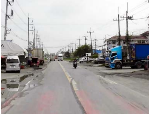
รูปก่อนการก่อสร้าง กม.ที่ ๓+๘๐๐
