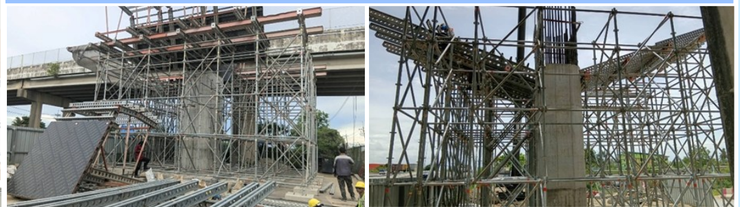
ตรวจสอบและควบคุมงานตั้งนั่งร้านก่อสร้าง PIER HEAD สะพานข้ามมอเตอร์เวย์ M7
