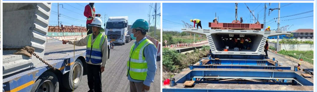
ตรวจสอบและควบคุมงานติดตั้งองค์อาคารคอนกรีตหล่อสำเร็จ ชนิด STANDARD SEGMENT ช่วง P1-P2 สะพานข้ามมอเตอร์เวย์ M7
