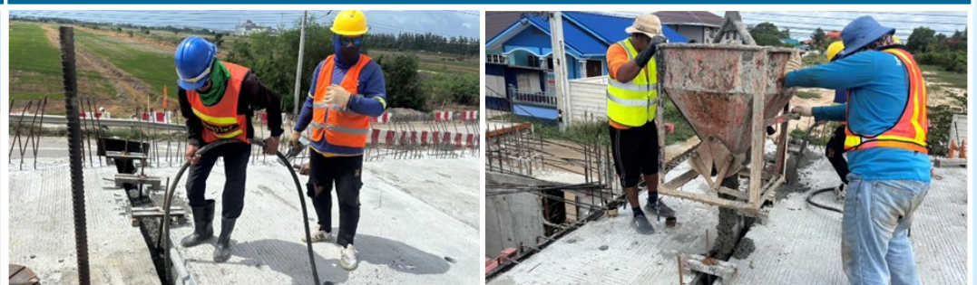
ตรวจสอบและควบคุมการเตรียมงานแบบหล่อ WET JOINT ช่วง P2-P3 สะพานข้ามมอเตอร์เวย์ M7
