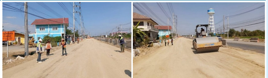
ตรวจสอบและควบคุมงานบดอัดทรายถมคันทาง
