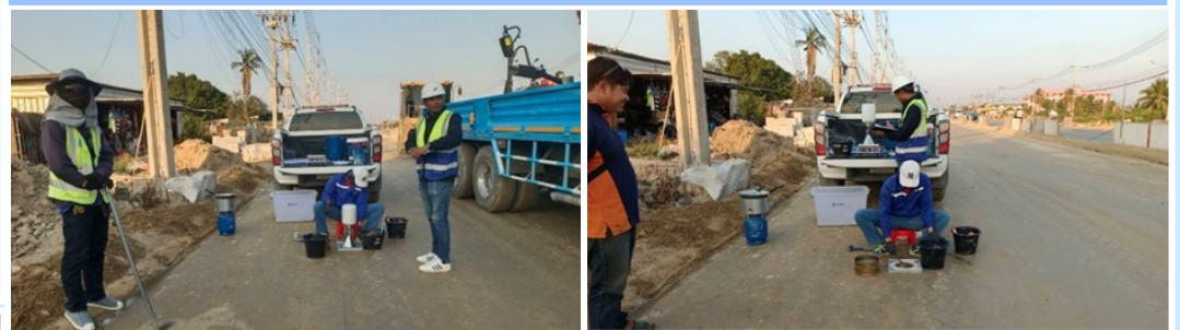
ตรวจสอบและควบคุมงาน Field Density Test ทรายถมคันทาง
