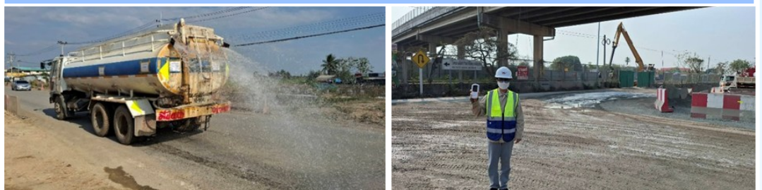
งานรดน้ำป้องกันฝุ่นเพื่อลดมลภาวะในการก่อสร้าง และตรวจสอบ PM. 2.5
