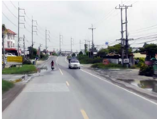
รูปก่อนการก่อสร้าง กม.ที่ ๒+๕๐๐
