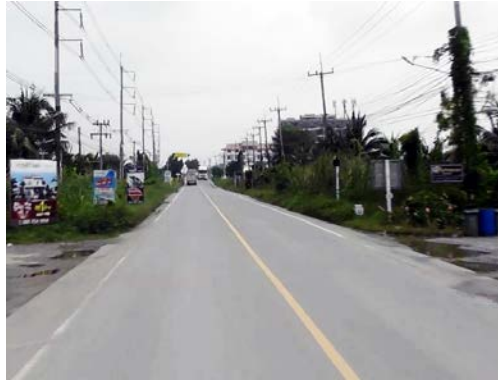
รูปก่อนการก่อสร้าง กม.ที่ ๓+๒๐๐
