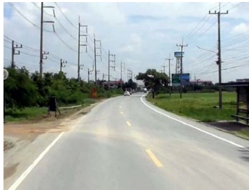
รูปก่อนการก่อสร้าง กม.ที่ ๕+๕๐๐
