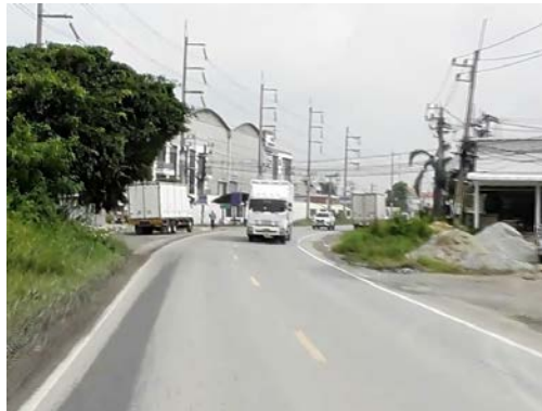
รูปก่อนการก่อสร้าง กม.ที่ ๒+๑๐๐
