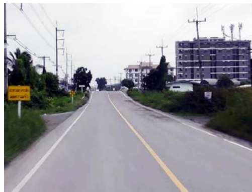
รูปก่อนการก่อสร้าง กม.ที่ ๓+๓๐๐
