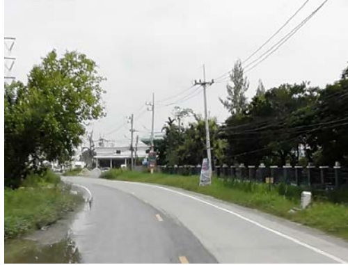
รูปก่อนการก่อสร้าง กม.ที่ ๒+๐๐๐
