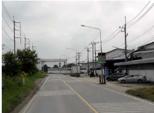
รูปก่อนการก่อสร้าง กม.ที่ ๐+๑๐๐
