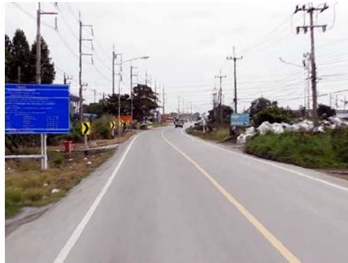
รูปก่อนการก่อสร้าง กม.ที่ ๖+๓๐๐
