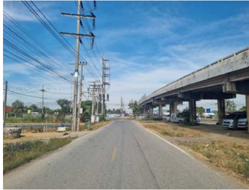
รูปก่อนการก่อสร้าง กม.ที่ ๔+๘๐๐
