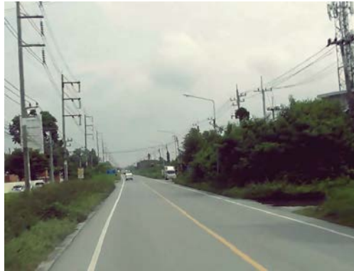
รูปก่อนการก่อสร้าง กม.ที่ ๐+๘๐๐
