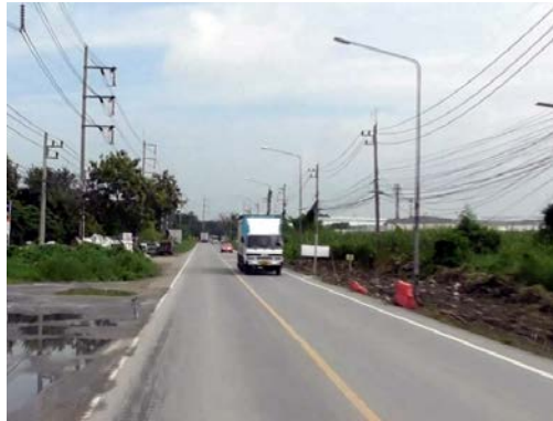
รูปก่อนการก่อสร้าง กม.ที่ ๐+๔๐๐
