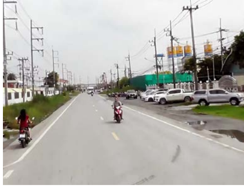
รูปก่อนการก่อสร้าง กม.ที่ ๒+๒๐๐
