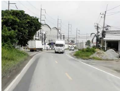
รูปก่อนการก่อสร้าง กม.ที่ ๒+๑๐๐
