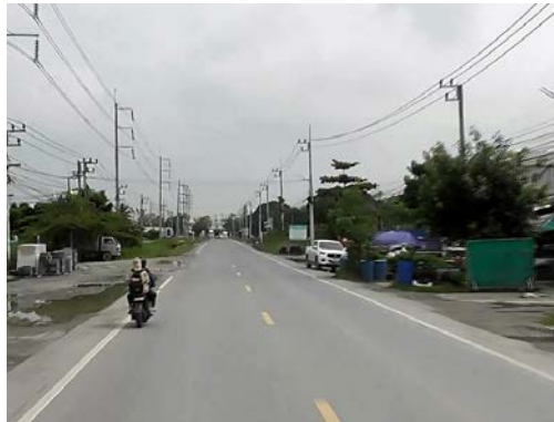
รูปก่อนการก่อสร้าง กม.ที่ ๑+๗๐๐
