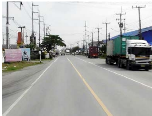
รูปก่อนการก่อสร้าง กม.ที่ ๓+๗๐๐
