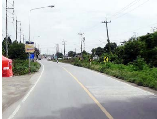
รูปก่อนการก่อสร้าง กม.ที่ ๖+๒๐๐
