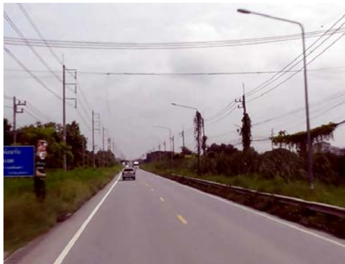
รูปก่อนการก่อสร้าง กม.ที่ ๐+๙๐๐
