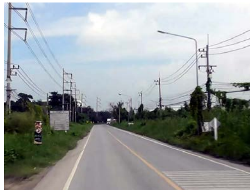
รูปก่อนการก่อสร้าง กม.ที่ ๐+๕๐๐
