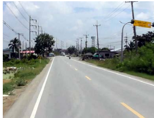
รูปก่อนการก่อสร้าง กม.ที่ ๕+๓๐๐
