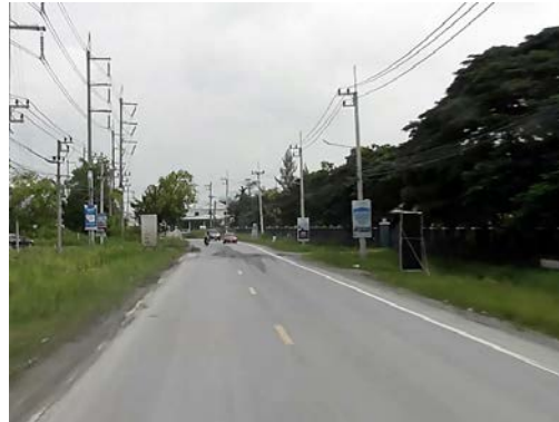
รูปก่อนการก่อสร้าง กม.ที่ ๑+๙๐๐
