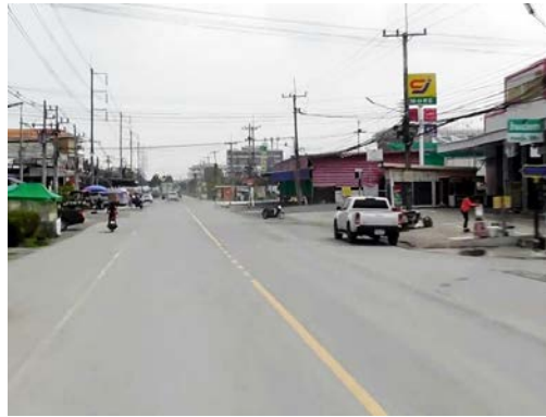
รูปก่อนการก่อสร้าง กม.ที่ ๓+๐๐๐
