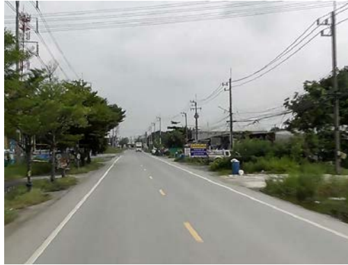
รูปก่อนการก่อสร้าง กม.ที่ ๑+๖๐๐
