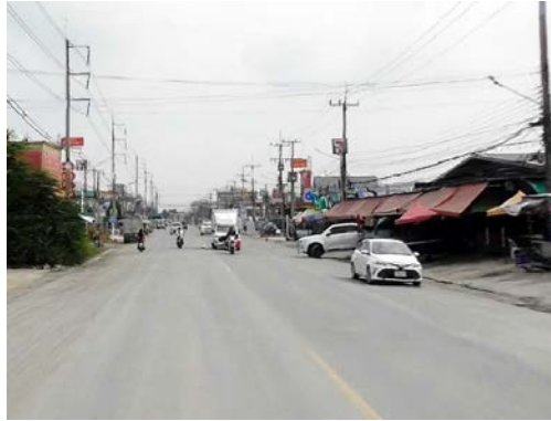
รูปก่อนการก่อสร้าง
