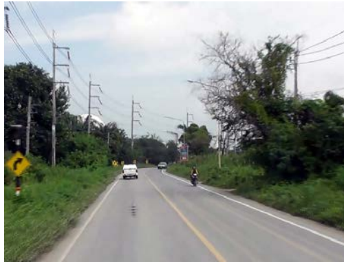
รูปก่อนการก่อสร้าง กม.ที่ ๐+๖๐๐
