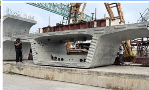
ตรวจสอบและควบคุมงานผลิตโครงสร้าง Segment ชนิด Standard Segment ช่วงความยาว 40.00 เมตร , 41.50 เมตร
