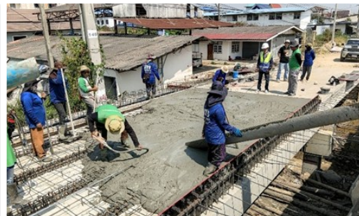
ตรวจสอบและควบคุมงานคอนกรีต Topping สำหรับ Box-Girder ยาว 20.00 เมตร (P2-P3) สะพานข้ามคลอง
