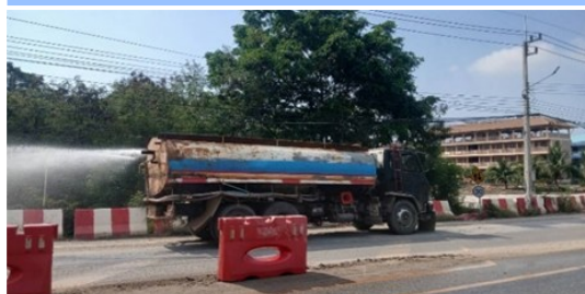
งานรตน้ำป้องกันฝุ่นเพื่อลดมลภาวะในการก่อสร้าง และตรวจสอบ PM. 2.5
