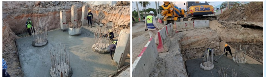
ตรวจสอบและควบคุมงานเทคอนกรีต Lean ร่องพื้นฐานราก A1
