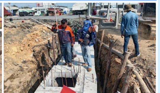
ตรวจสอบและควบคุมงานท่อเหลี่ยมคอนกรีตเสริมเหล็กระบายน้ำด้านข้าง ขนาด 1-1.20x1.20 เมตร
