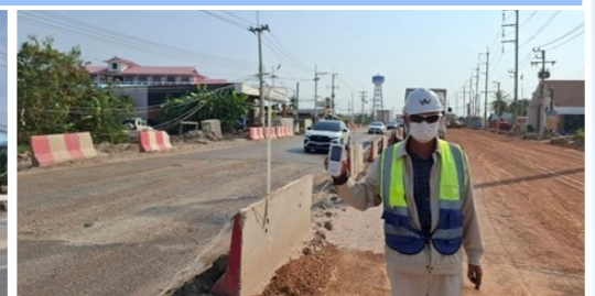
งานรตน้ำป้องกันฝุ่นเพื่อลดมลภาวะในการก่อสร้าง และตรวจสอบ PM. 2.5
