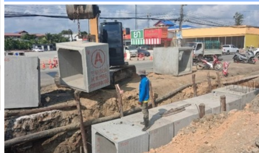
ตรวจสอบและควบคุมงานท่อเหลี่ยมคอนกรีตเสริมเหล็กระบายน้ำด้านข้าง ขนาด 1-1.20x1.20 เมตร
