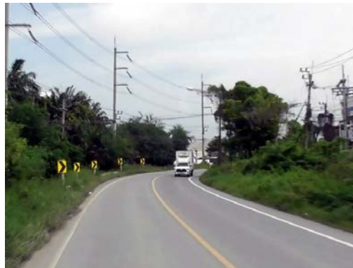
รูปก่อนการก่อสร้าง กม.ที่ ๐+๗๐๐
