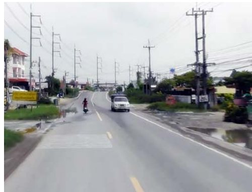
รูปก่อนการก่อสร้าง กม.ที่ ๒+๕๐๐
