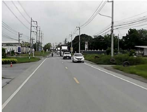
รูปก่อนการก่อสร้าง กม.ที่ ๑+๘๐๐
