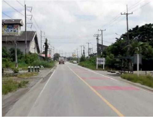
รูปก่อนการก่อสร้าง กม.ที่ ๕+๒๐๐
