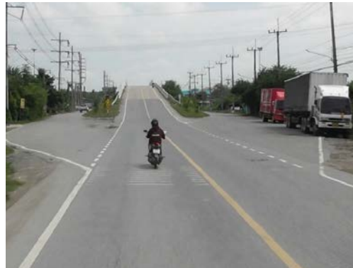
รูปก่อนการก่อสร้าง กม.ที่ ๔+๗๐๐
