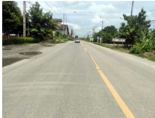
รูปก่อนการก่อสร้าง กม.ที่ ๕+๑๐๐
