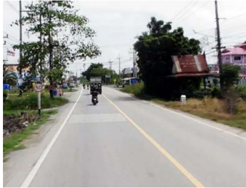
รูปก่อนการก่อสร้าง กม.ที่ ๖+๐๐๐
