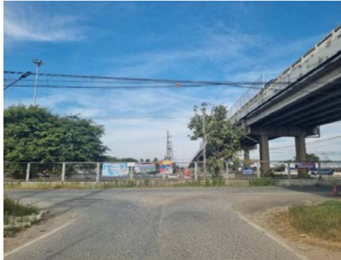
รูปก่อนการก่อสร้าง กม.ที่ ๔+๙๐๐
