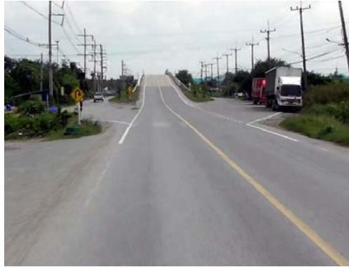
รูปก่อนการก่อสร้าง กม.ที่ ๔+๖๐๐
