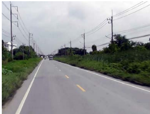
รูปก่อนการก่อสร้าง กม.ที่ ๑+๑๐๐
