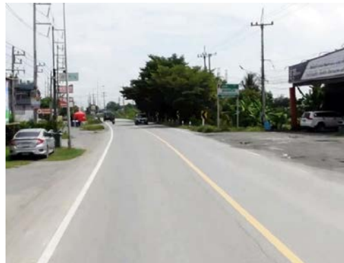
รูปก่อนการก่อสร้าง กม.ที่ ๖+๑๐๐
