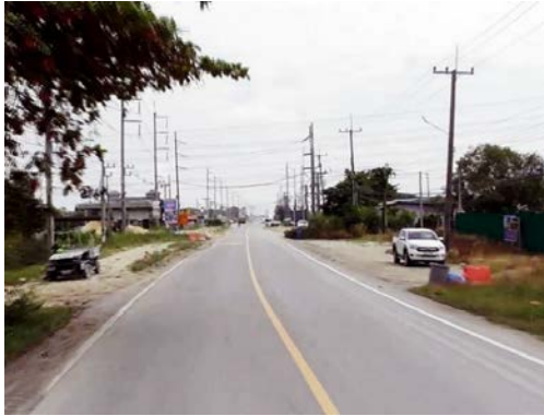
รูปก่อนการก่อสร้าง กม.ที่ ๖+๔๐๐
