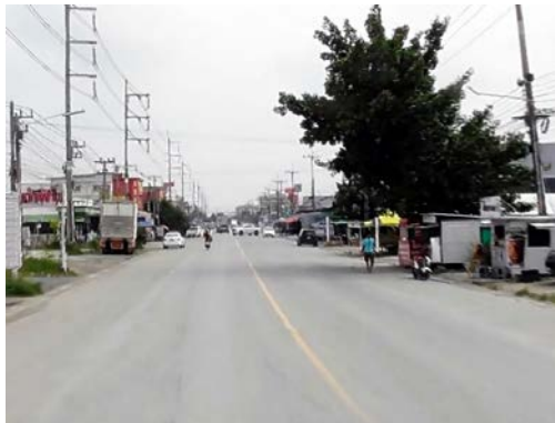
รูปก่อนการก่อสร้าง กม.ที่ ๒+๗๐๐
