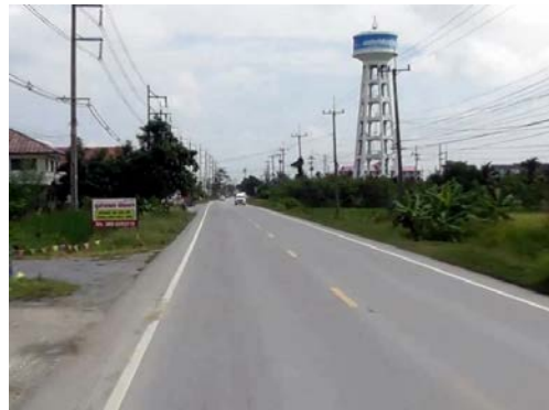
รูปก่อนการก่อสร้าง กม.ที่ ๕+๗๐๐
