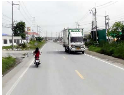
รูปก่อนการก่อสร้าง กม.ที่ ๒+๓๐๐
